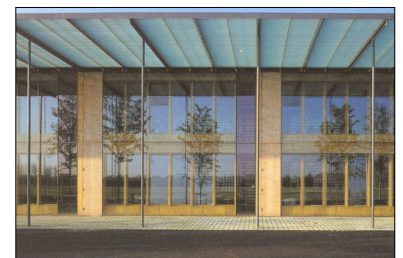
Haupteingang in der zentralen Halle
